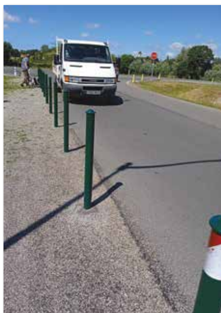
Pose de poteaux pour la sécurité des piétons aux Samériaies
