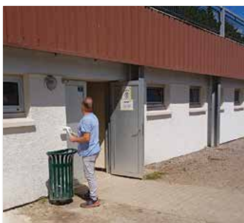
Remise en peinture des locaux du stade basilien intérieur et extérieur
