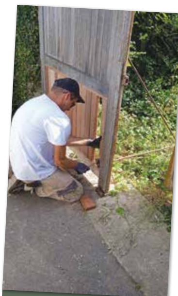
Réparation des portes de la station de refoulement rue de Questrecques
