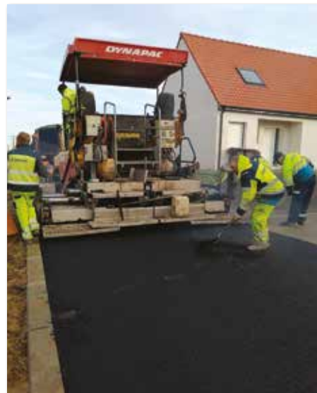
Enrobé résidence du Parc : 300 tonnes + pose de candélabres et réalisation de trottoirs, encore quelques travaux à terminer. Coût : 270 000€
