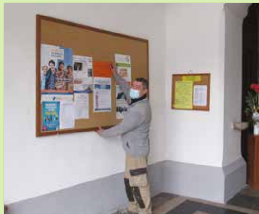
Remise en peinture du hall de l'église par le personnel de la ville
