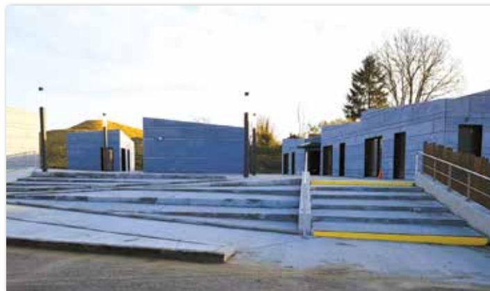
Avancée des travaux au mois de Décembre
