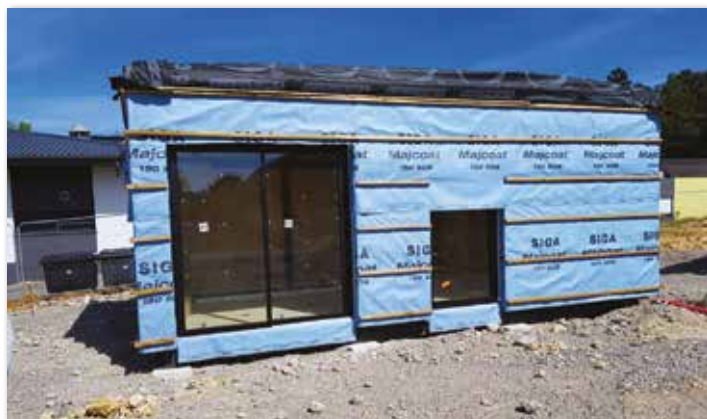
Avancée des travaux au mois d'Août
