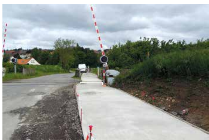
Liaison douce terminée route de Longuerèques au passage à niveau
