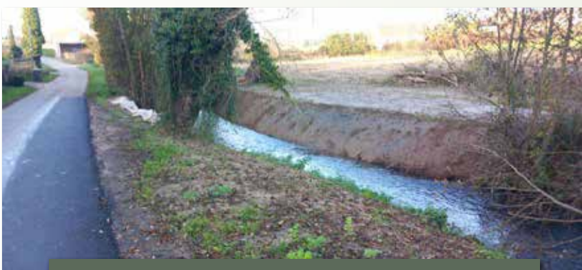
Renforcement des berges à Bellozanne suite aux inondations
