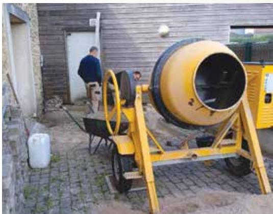
Aménagement d'un accès pour les personnes à mobilité réduite à l'arrière du musée
