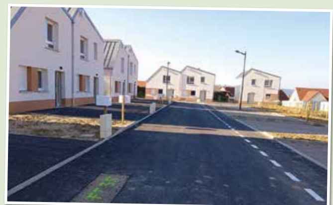
Avancement des travaux aux Samérialles
