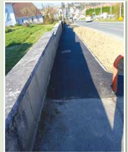
Réalisation d'un trottoir au passage à niveau rue de Desvres
