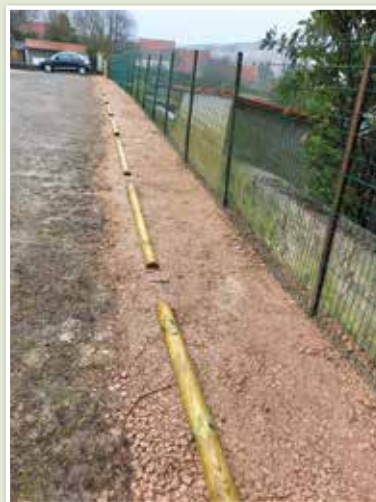
Travaux d'aménagement du parking de la salle de restauration
