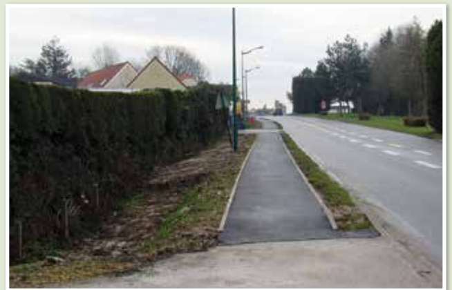
Réalisation de trottoirs rd 901 (coté Batireno) et changement des candélabres
