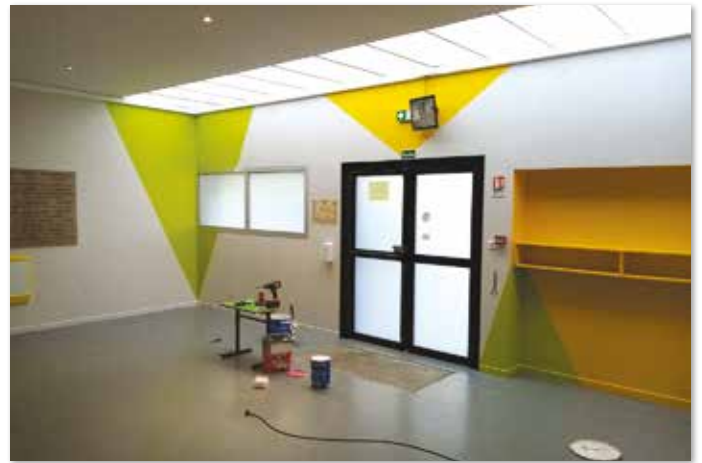
REMISE en PEINTURE dans le hall de l'école maternelle
