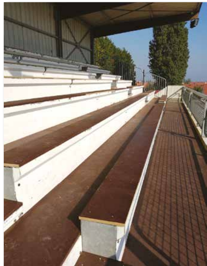
REMISE en ÉTAT des gradins du stade basilien
