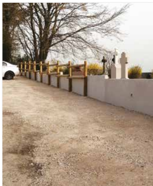
Travaux du mur du cimetière terminé avec mise en sécurité (partie haute)
