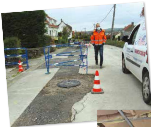
Amélioration des canalisations rue de Carly
