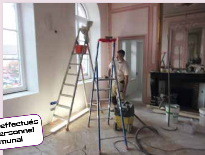
Rénovation des bureaux de la mairie
