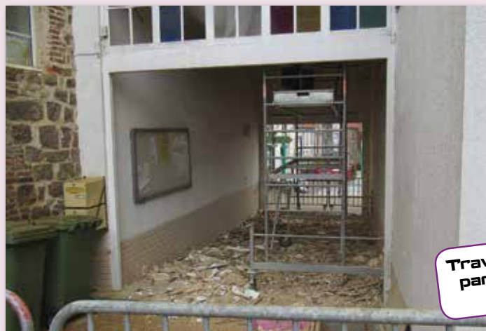
Remise en état de la voûte au passage, allée Jean Bardol
