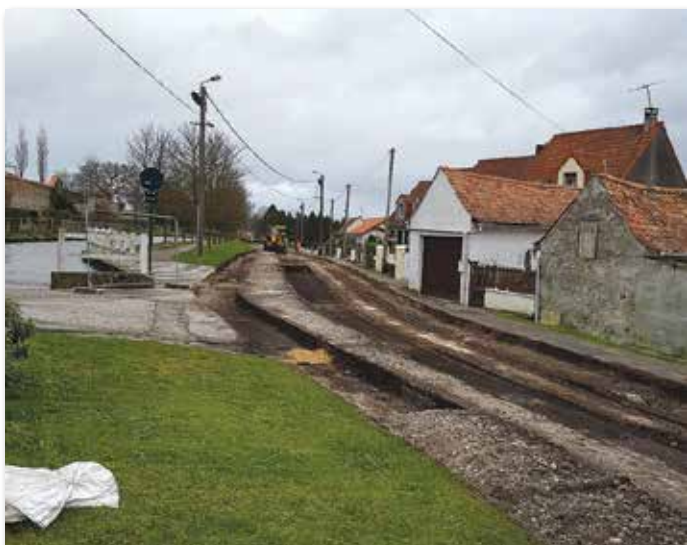
Travaux rue du Collège
