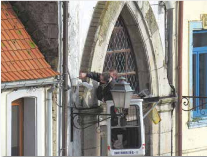
Pose d'une caméra à l'entrée de l'église
