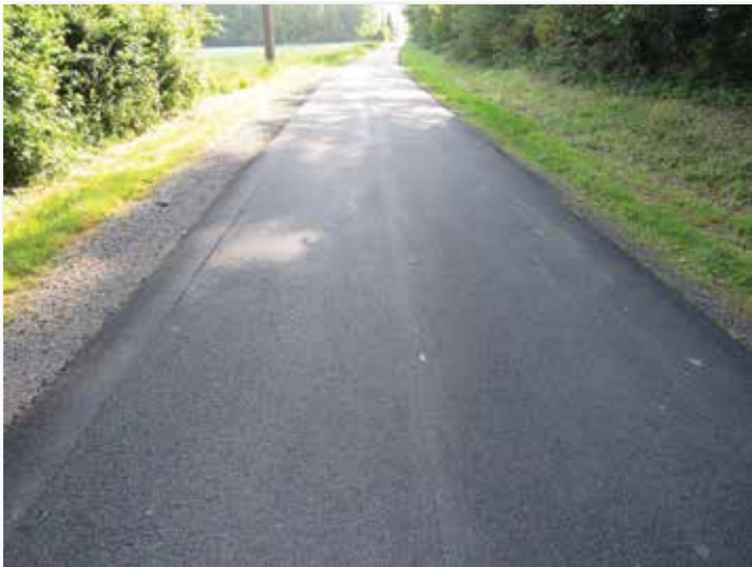
Remise en état de la route du Pilbois
