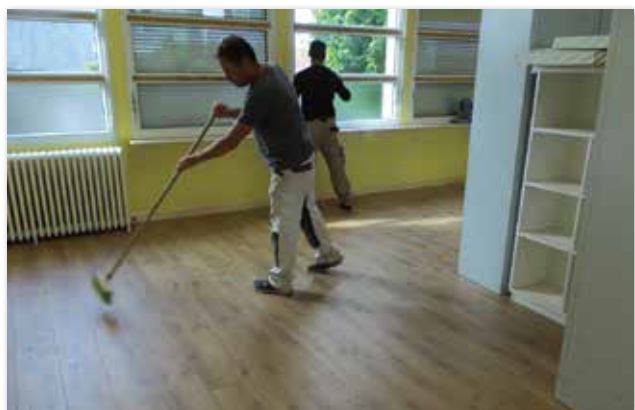
Changement du plancher d'une classe à l'école Coustès
