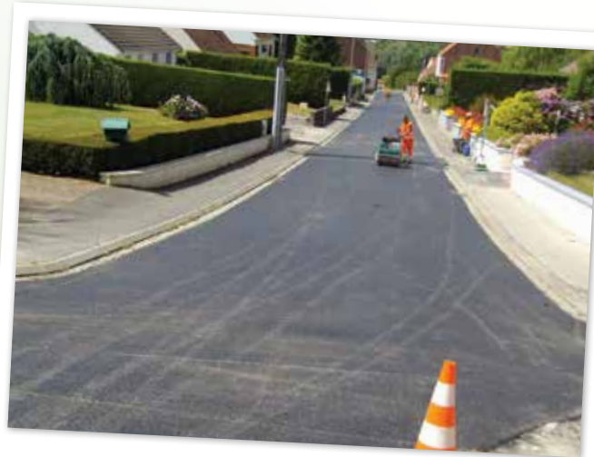
Réfection de la rue des allées
