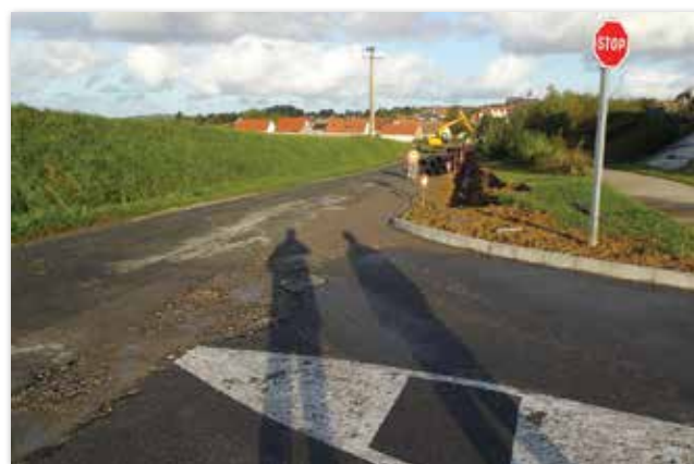
Elargissement de la route de Longuerèques
