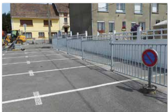
Pose de barrières de sécurité pour les enfants de l'école Coustès
