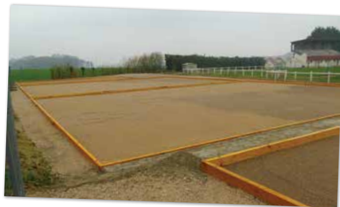
Avancement des travaux des nouveaux terrains de pétanque
