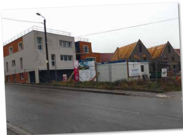
Avancement de la construction de la résidence Le Parc avec 11 logements collectifs et 8 logements individuels
