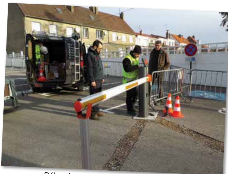
Début de réalisation d'un chemin sécurisé pour l'accès des enfants de l'école Coustès
