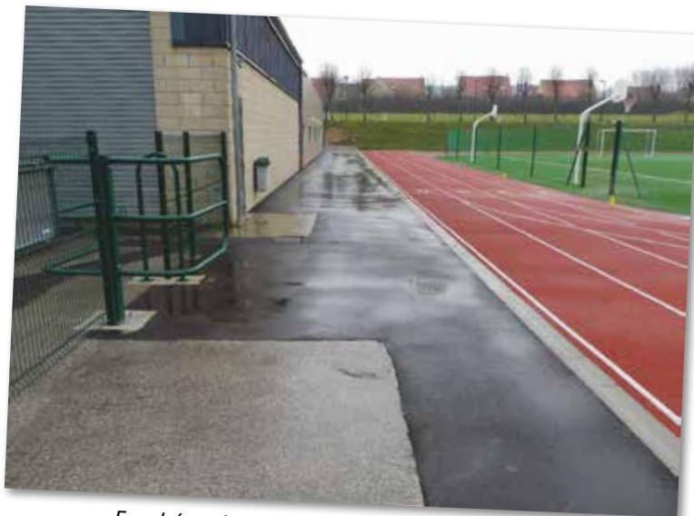
Enrobé sur le chemin pour accéder à l'extension de la salle Lemanski
