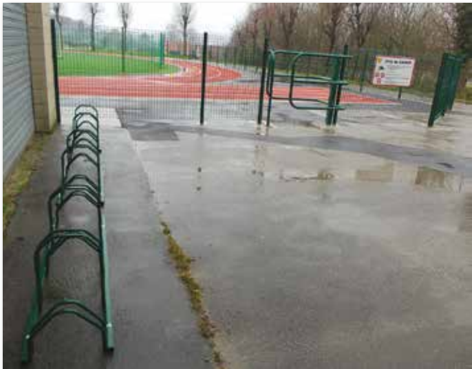
Installation de porte-vélos et passage pour handicapé pour se rendre au terrain multisports
