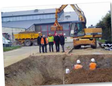
Création d'un bassin de rétention à la salle Lemanski
