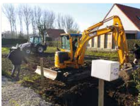
Création d'un parking rue de Neufchâtel
